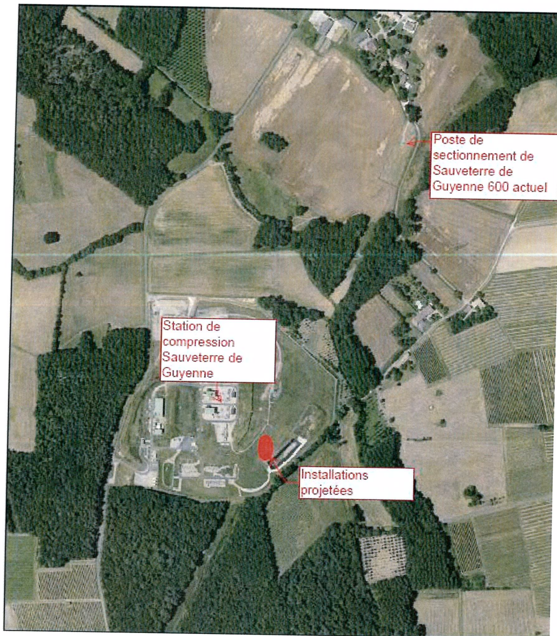
Vue aérienne des installations aériennes TEREGA à Sauveterre-de-Guyenne
